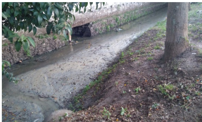
Figura 6 - Assoreamento em trecho do córrego Tenente Rocha
